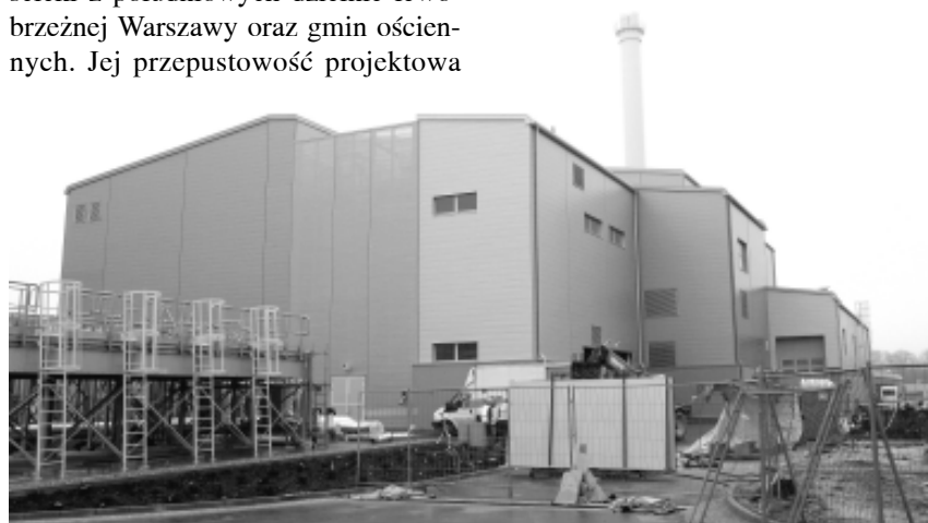
Spalarnia osadów pościekowych rozwiązuje problem odpadów i... daje prąd.
