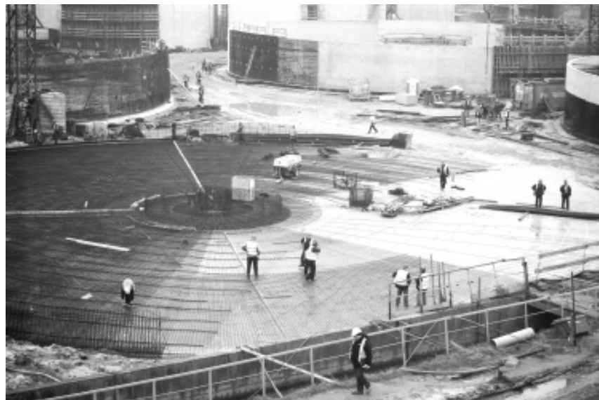
Trwają roboty betoniarskie przy zbiornikach napowietrzających...
