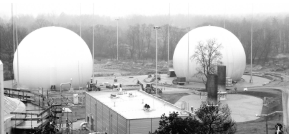
W tych wielkich kulistych zbiornikach magazynowany jest oczyszczony gaz powstały w procesie fermentacji ścieków.
