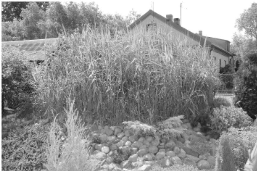
Przydomowa trzcinowa oczyszczalnia ścieków bytowych.
