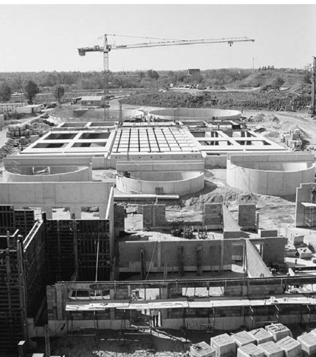
Plac budowy mechaniczno-biologicznej oczyszczalni ścieków Pomorzany.
