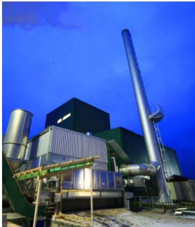
Elektrociepłownia w tartaku "Olczyk" to przykład prosumenckiego podejścia do energetyki rozproszonej.
