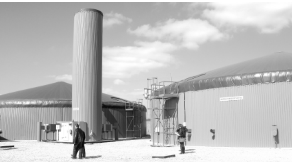
Biogazownie rolnicze to instalacje do produkcji biogazu, w których proces technologiczny oparty jest na fermentacji.
