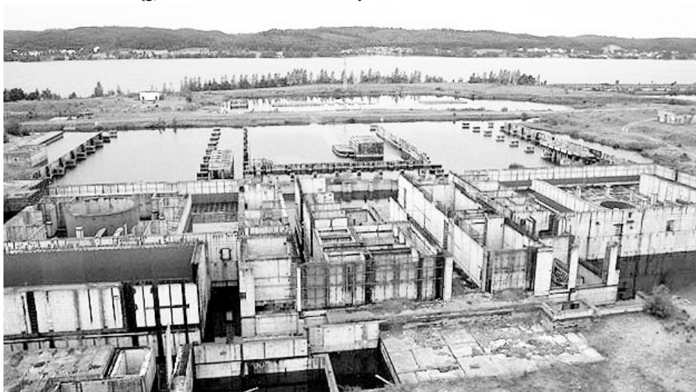
Po elektrowni w Żarnowcu pozostały tylko zgliszcza. Na zdjęciu zalane fundamenty głównego bloku elektrowni, widoczne okrągłe struktury to pozostałości po fundamentach reaktorów.
