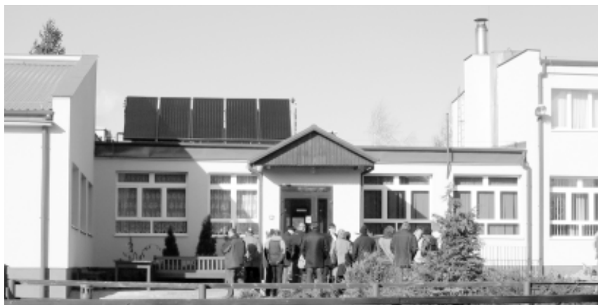
Kolektory słoneczne na dachu Ośrodka Szkolno-Wychowawczego w Barcicach, powiat Kwidzyn.
