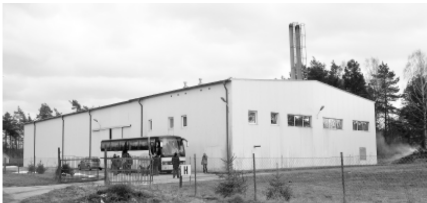
Kotłownia na słomę w Waplewie Wielkim, powiat Sztum. Jej budowę dofinansował m.in. EkoFundusz.
