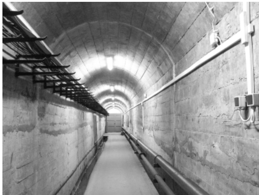
Galeria techniczna w zaporze, na głębokości 6 m pod dnem zbiornika solińskiego.
