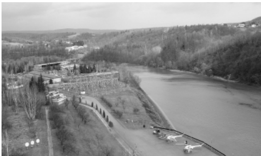
Dopiero spacerując po koronie zapory i patrząc z jej wysokości na rozległy horyzont widać, jak ogromna jest to budowla.
