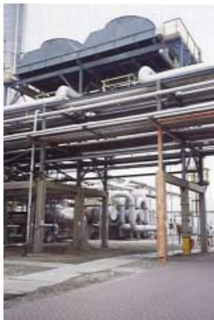
Rys. 2.13 Przykład zastosowania systemu chłodzenia cieczy powietrzem w przemyśle chemicznym [Archiwum Pers.]
