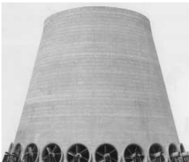
Rysunek 2.7: Wieża chłodnicza z grawitacyjnym przepływem powietrza i wentylatorem pomocniczym [tm103, BDAG, 1996]
