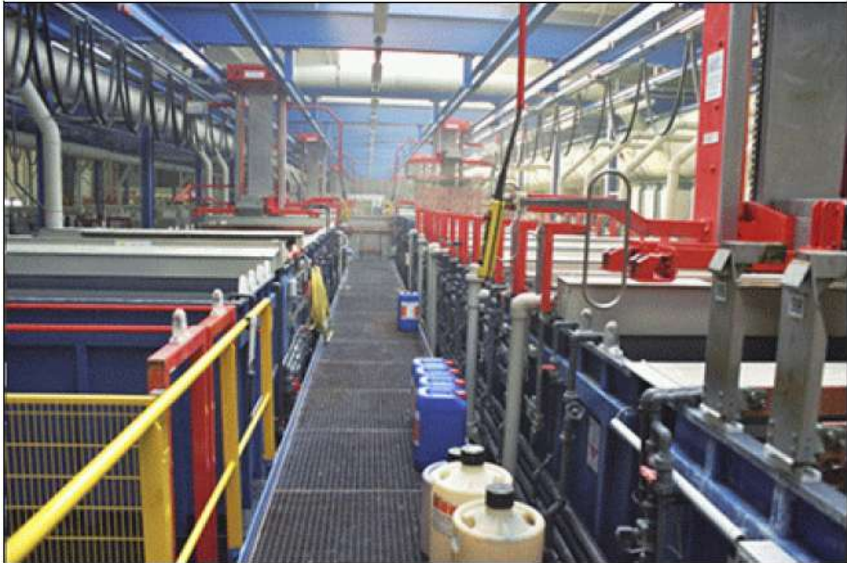
Rysunek 4.33: Linia przyrządów obróbkowych z pokrywami na zbiornikach i ekstrakcja powietrza
