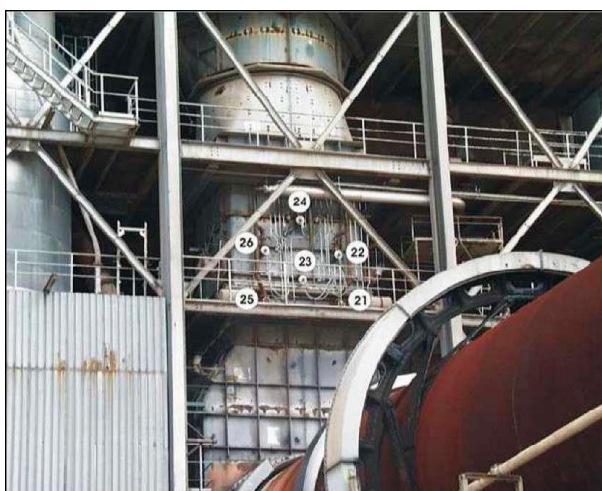
Rysunek 4.8: Wysokowydajna technologia SNCR i miejsce wstrzykiwania wody amoniakalnej przez lance w punktach nr 21 do 26
