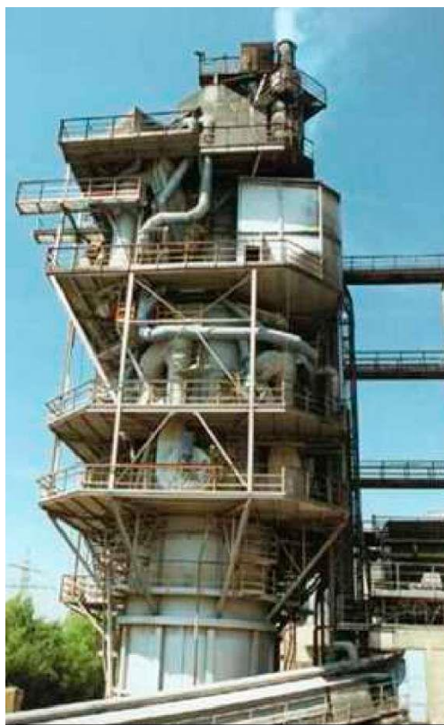
Rysunek 2.26: Przykład pieca szybowego pierścieniowego używanego do produkcji wapna [44, EuLA, 2006]
