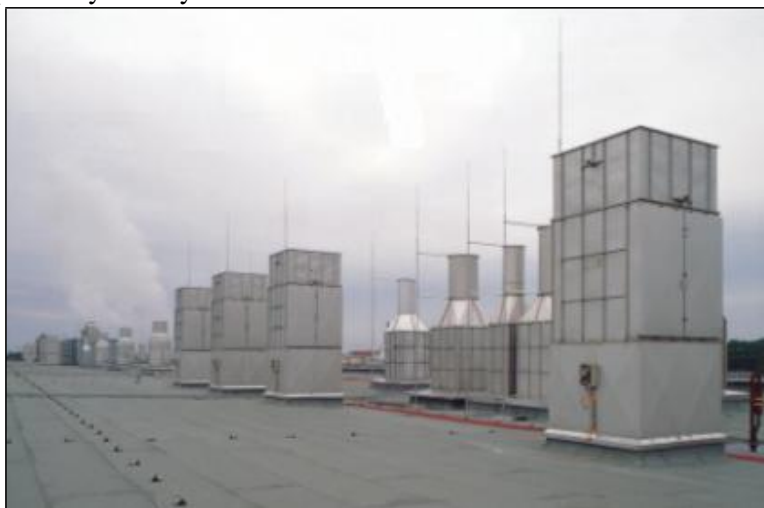
Rysunek 7.37 Tłumiki na dachu papierni.
