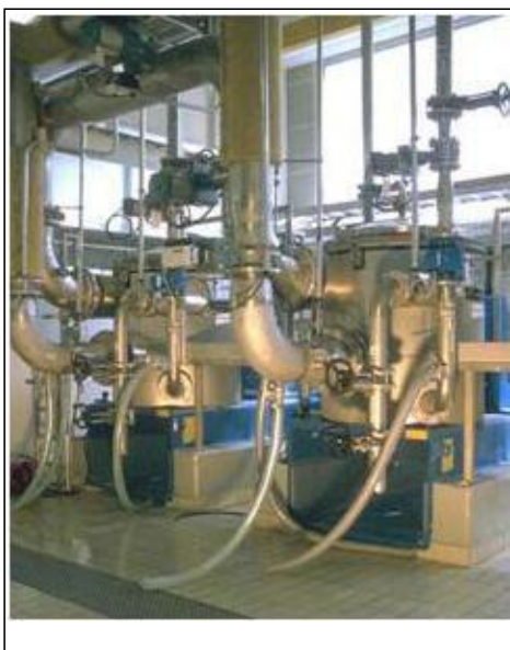
Rysunek 4.7 Sortownik ciśnieniowy do końcowego przesiewania
