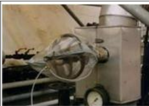
Rys. 3.38: Workowanie przeciekającego zaworu
