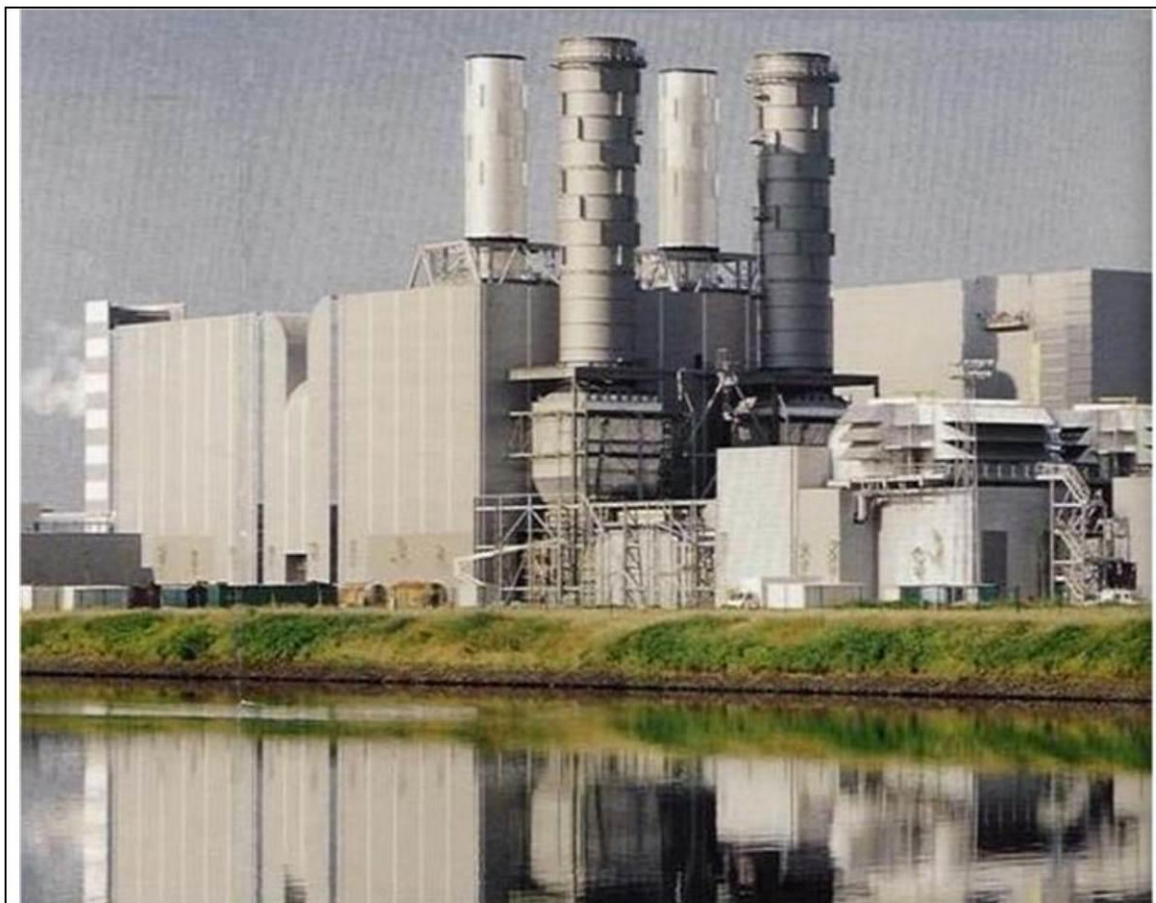
Rysunek 2.16: Elektrownia z turbiną gazową o cyklu łączonym wybudowana niedawno w Belgii
