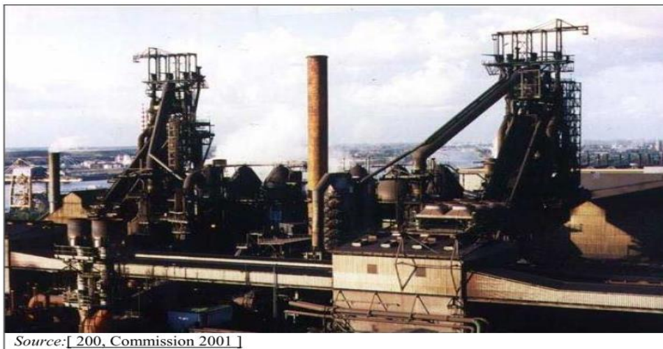
Rysunek 6.1: Widok dwóch wielkich pieców, każdy z trzema nagrzewnicami dmuchu wielkopiecowego i kominem uwalniającym spaliny z nagrzewnic dmuchu
