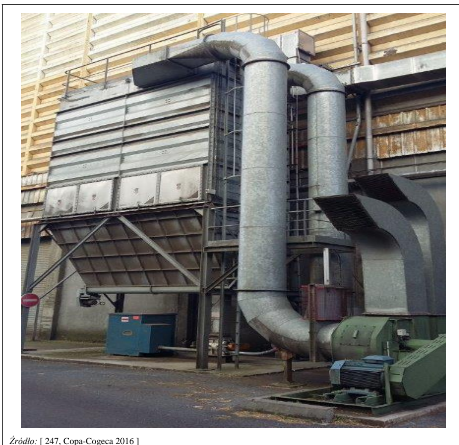
Rysunek 2.43: Zdjęcie przemysłowego filtra workowego
