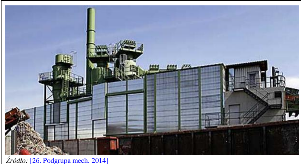
Ilustracja 3.23: Ekrany ochronne w zakładzie rozdrabniającym Schrott-Bosch GmbH, Niemcy
